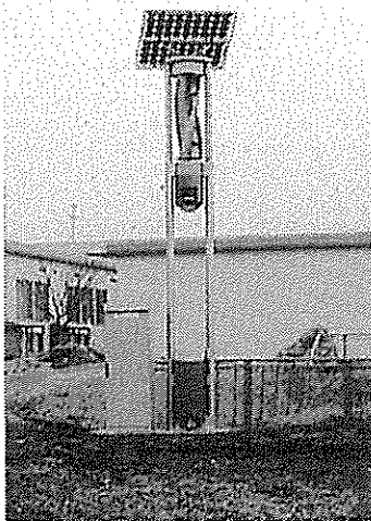
上部に取り付けられた正方形の板がソーラーパネル。円筒をねじった形の風力発電装置の下部にカメラがある。長岡市の下助川脇
